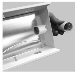
4. Fazer a conexão elétrica em todos os soquetes e na fiação da caixa de luz (teto).
