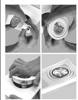
8. Conectar e montar a lâmpada AR111/LED do spot finalizando a montagem da luminária.
