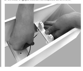
3. Coloque o "pé de galinha" na furação da caixa de luz e fixar a luminária no teto unindo a parte elétrica.
